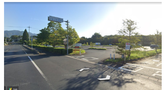
グリーンヒルズ津山北第一駐車場
